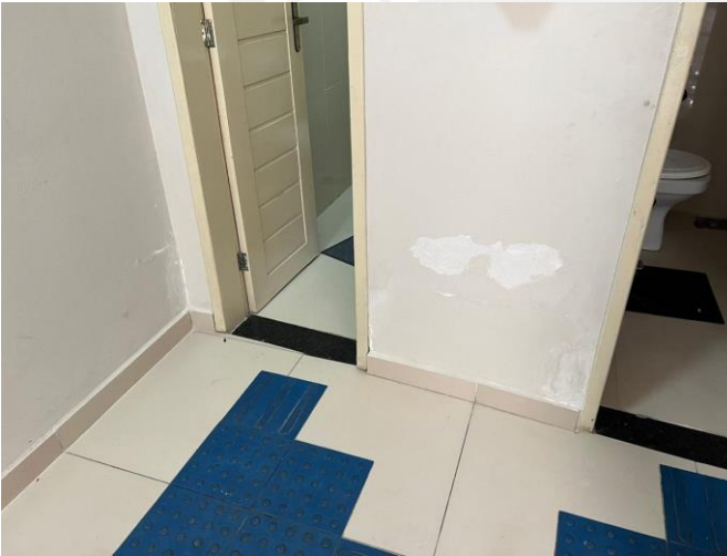
Fotos 05 a 11: Paredes com infiltrações, eflorescências e pinturas danificadas:
