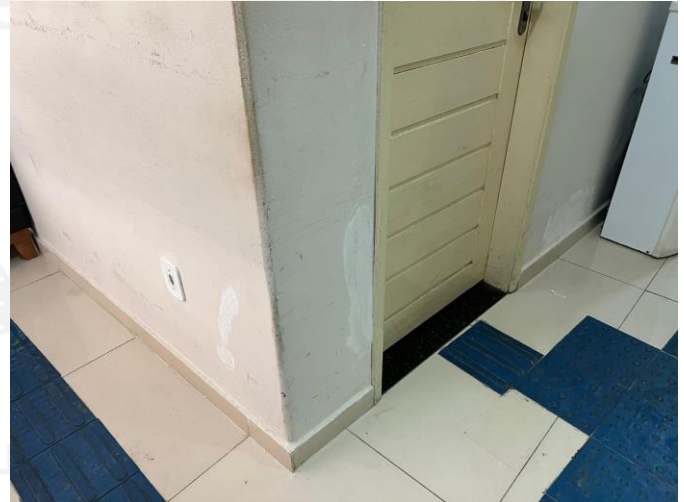
Fotos 05 a 11: Paredes com infiltrações, eflorescências e pinturas danificadas:
